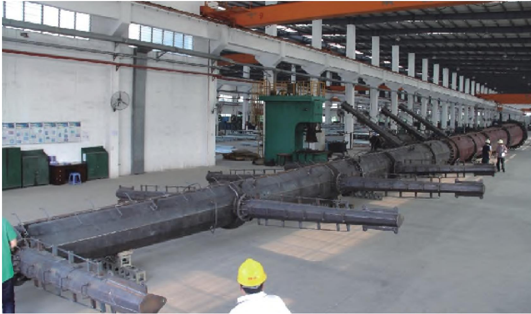
220KV 钢管杆组装现场
